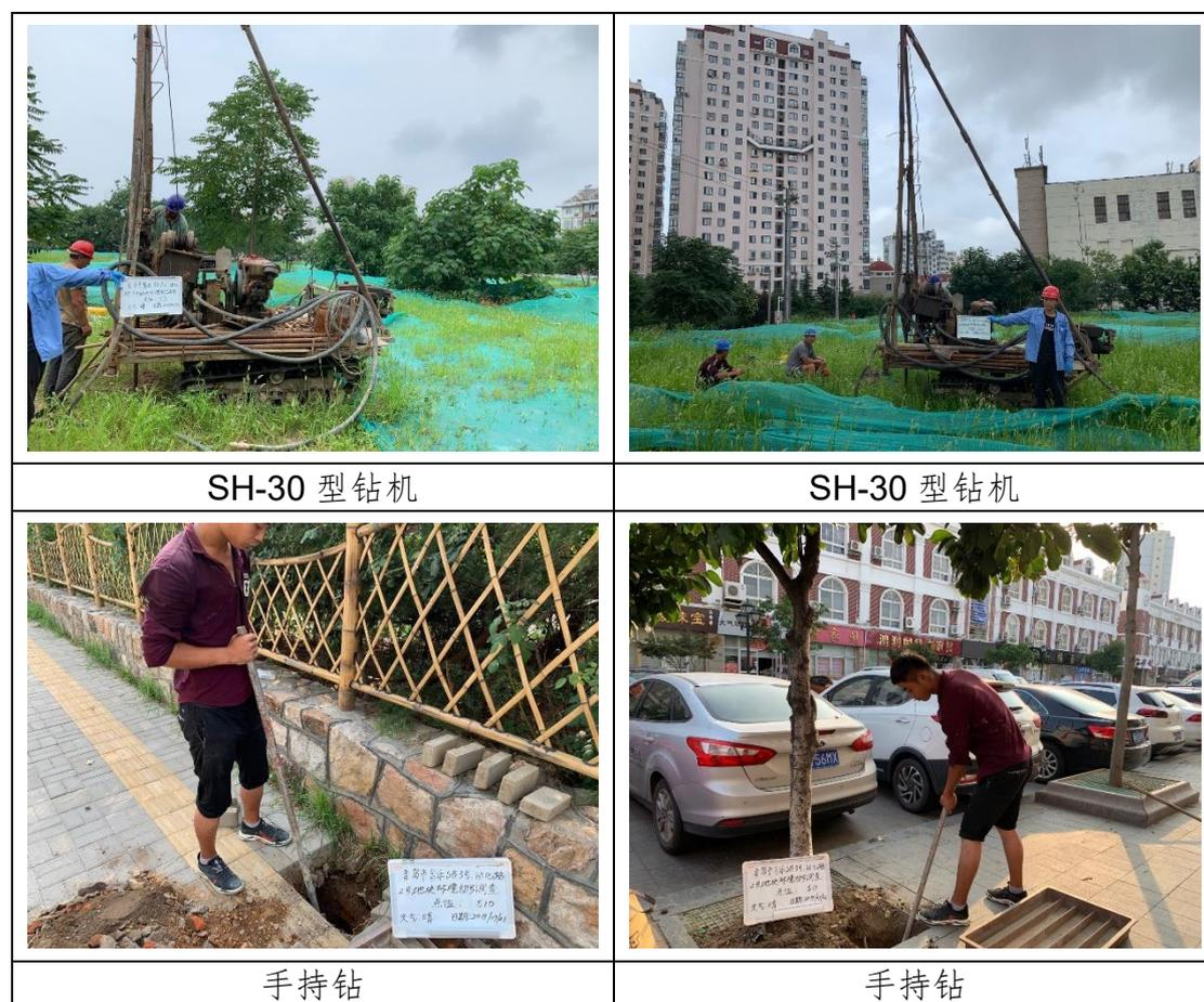
图4-7 土壤孔钻探方式
